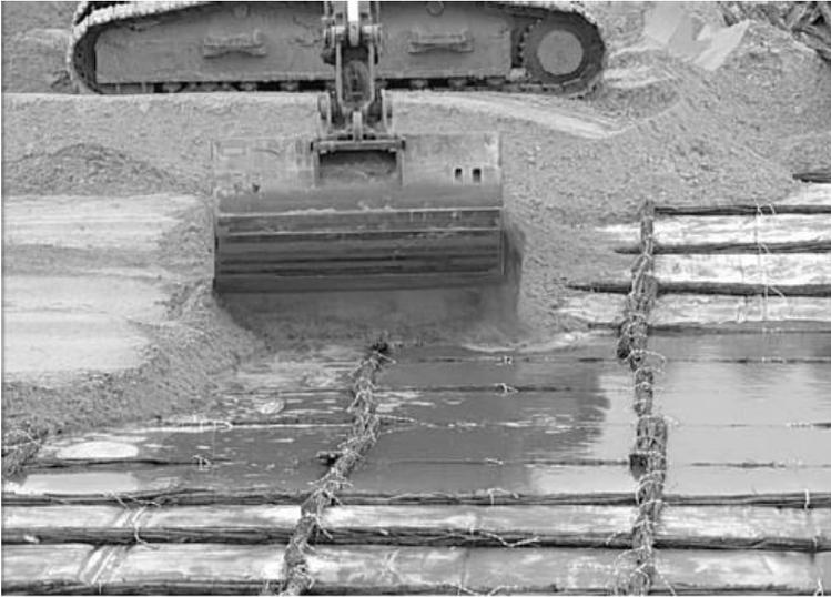
Рис. 2 Схватывание песчаного материала и выдавливание воды
