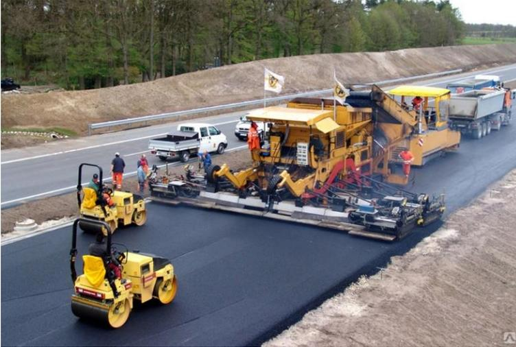
Рис. 1 Технологический процесс укладки асфальтобетонного покрытия
