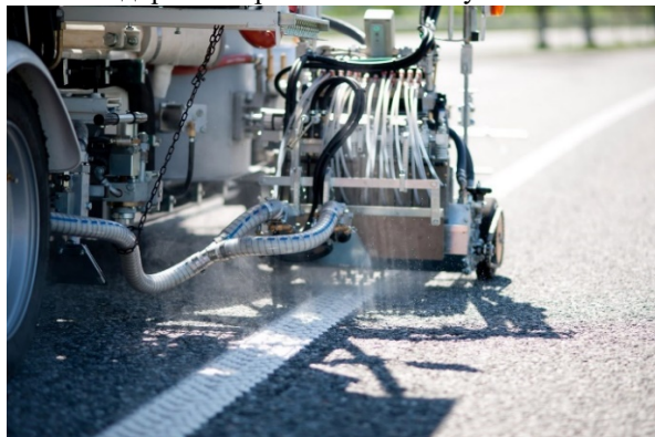
Рис. 1. Нанесение термопластика на дорожное покрытие [3]
