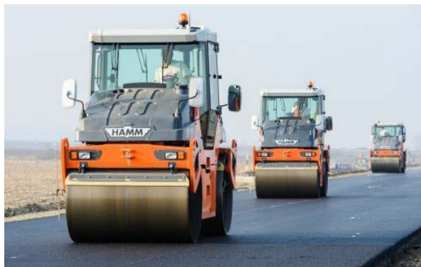
Рис. 4. Дорожный каток в процессе уплотнения дорожного покрытия [5]
